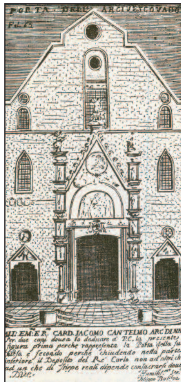
Facciata della Cattedrale prima dell'intervento di E. Alvino
